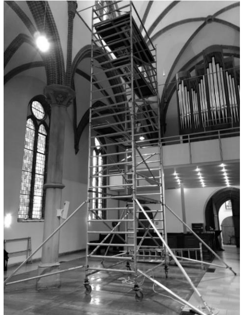
Arbeiten unter dem Dachgewölbe Foto: Gerald Meier
